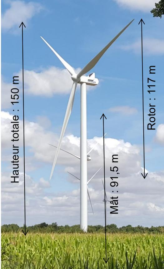
Les éoliennes choisies pour le projet d'Estables ont une hauteur en bout de pale de 150 mètres pour une puissance unitaire de 4,2 MW.
