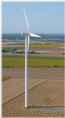
**L'éolien est une énergie qui utilise peu d'espace au sol par rapport aux autres énergies.** Une éolienne occupe au sol une surface de 2 500 m<sup>2</sup> soit 0,25 ha pour une puissance d'environ 3 MW.
